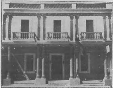
Vista del nuevo edificio de la sucursal del Banco Nacional en Santo Domingo, de la cual nos ocupamos en la página "A través de la Isla".
